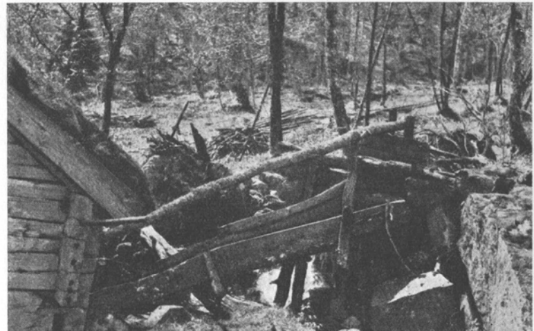
Bild 7. Kvarnrännan och »pådraget», stängen varmed rännluckan öppnas. Veka, Breared sn, Halland.
