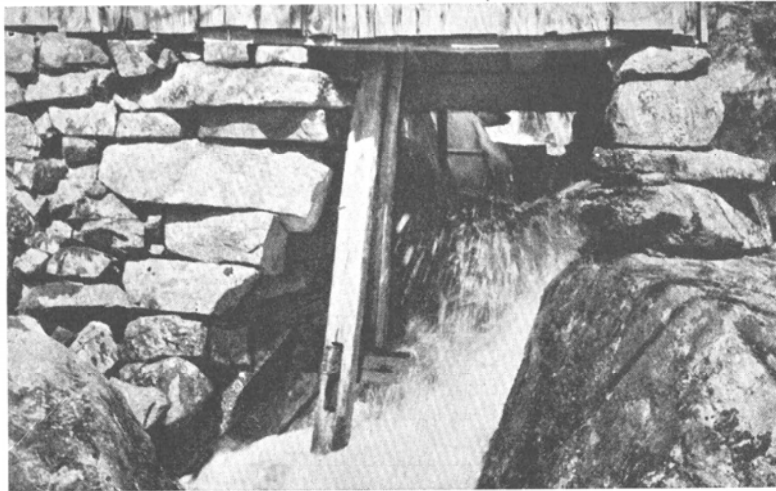
Bild 3 o. 4. Skvaltkvarnen går. Vattnet står i en kaskad kring drivhjulet, när kvarnen är i gång. Svalilt, Breared sn, Halland.
